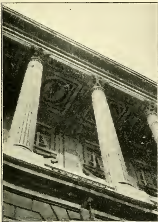
Abb. 197 Detail vom Garde-meubles in Paris
