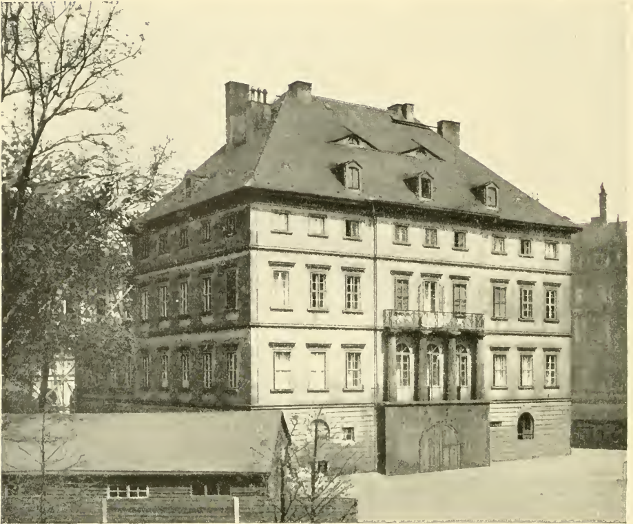
Abb. 216 Verwaltungsgebäude in Dresden (Ans: Mebes, Um 1800)
