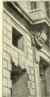
Abb. 198 Detail vom Garde-meubles in Paris
